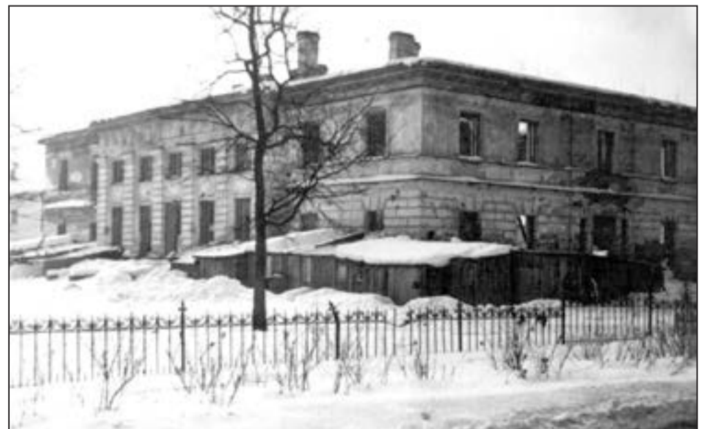
Здание ДК, строительство которого начато в 1932. Фото 1944. Копия из фондов архива МБУ Музей города Гатчины
